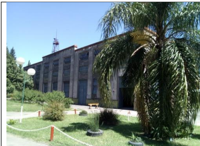
Edificio del ex Ferrocarril Laguna Paiva
